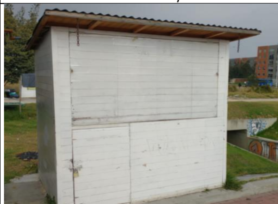
CASETA No. 94 color blanca en madera retirada de la carrera 94 entre calles 80 y 81 Sur.
