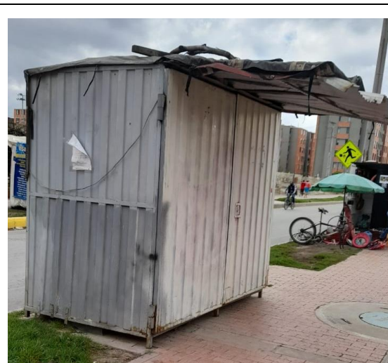
Caseta No.26 , de color gris fabricada en metal, retirada de la carrera 94 entre calles 83 y 85 Sur.
